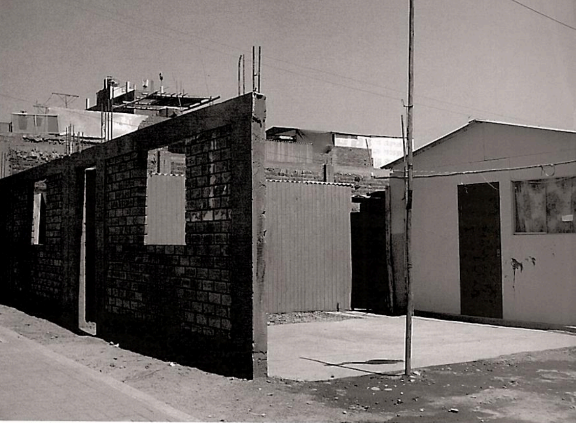
En Pisco, poco o nada ha cambiado después del sismo del 2007. La ineficiencia llevada al máximo. En foto de Mario Zolezzi se observa el degradante "muro de la dignidad" para sombrear lo no rehabilitado.
